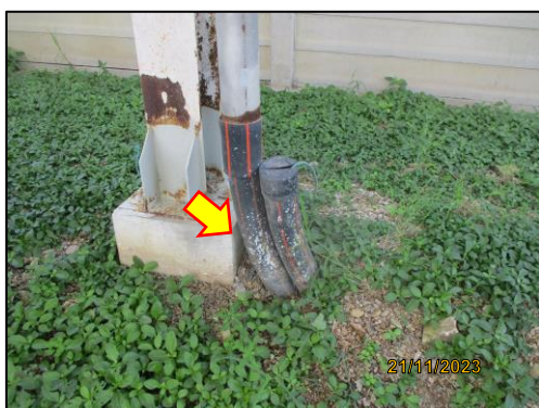
รูปที่ 2-24 ระบบสายดินบริเวณสถานีไฟฟ้าย่อย (Grounding System)
