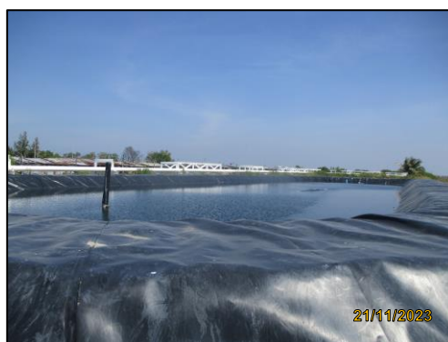
รูปที่ 2-22 บ่อน้ำสำรองดับเพลิง
