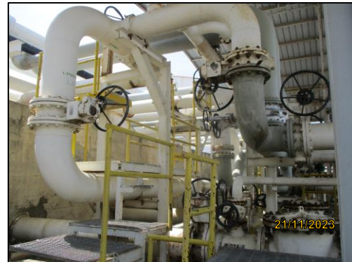
รูปที่ 2-2 วาล์วของระบบท่อส่งน้ำมัน (Pump PAD No.5)
