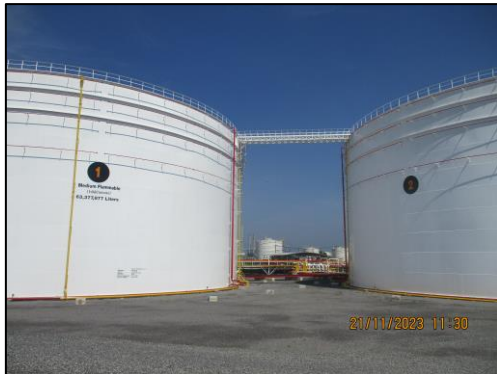
รูปที่ 2-1 ถัง Floating roof
